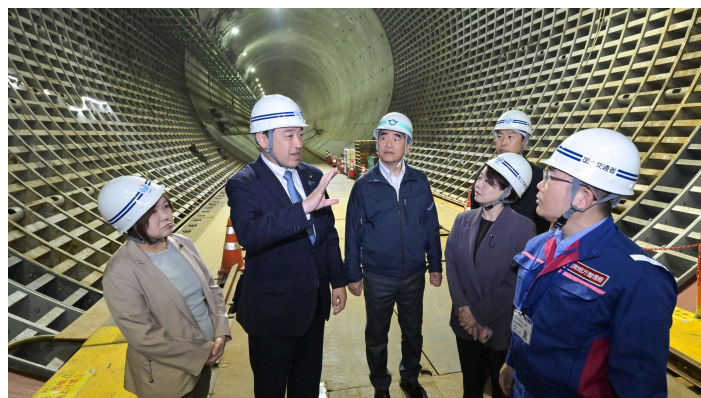
横浜湘南道路の建設現場にて。神奈川の利便性を向上へ。道路ネットワークの更なる充実に全力。（2026年4月20日）
